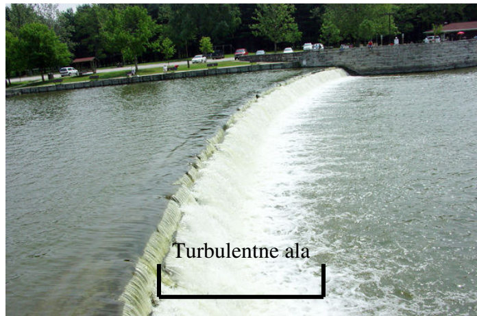
Joonis 6. Paisust allalangeva vee toimel tekkev turbulentne alavees
