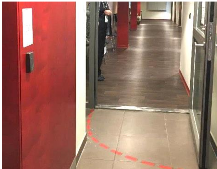
Tallinna sotsiaalameti automaatselt avaneva koridoriukse nn avanemiskaare tähistus põrandal ja „näita kaarti” tekst seinaanduril (paigalduskõrgus 1100 mm).
