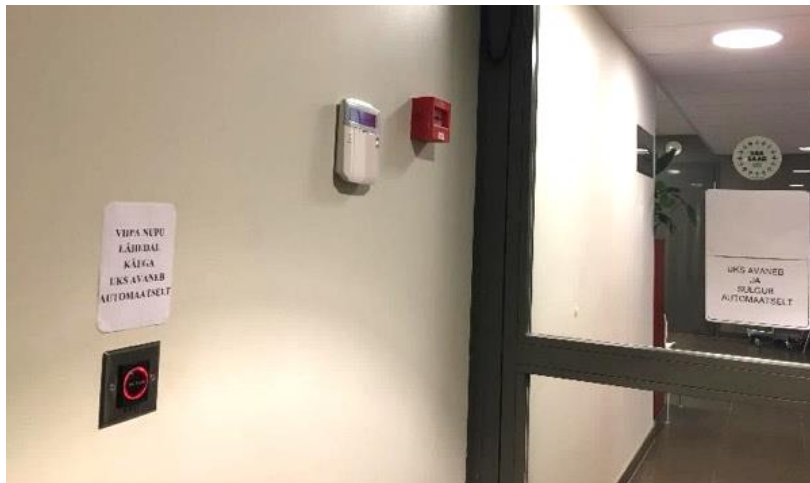
Tallinna sotsiaalameti automaatukse avamise kontaktivaba andur (ei pea kätt anduri vastu panema), hoiatustekst uksele.
