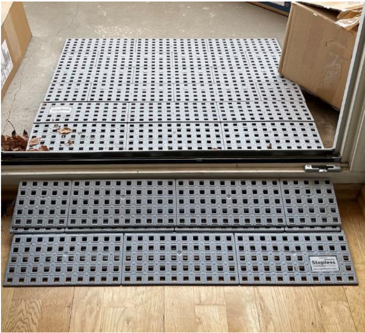
Näide rõdu läve tasandamisest plast moodulrampidega.
