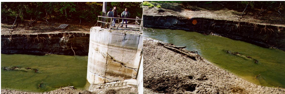
Joonis 5. Näide paisutamise kaasnevast setetereostusest: Kunda hej paisu avamisega 2003. a kaasnes tuhandete m 3 liivasetete kandumine paisust allavoolu asuvatele kärestikele. Sellega rikuti mitmeks aastaks allavoolu jääva jõeosa elupaigaline kvaliteet (R. Järvekülg, 2003).
