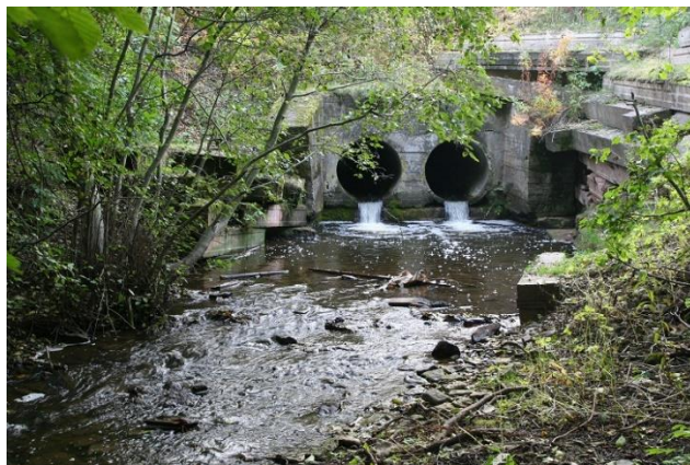
Joonis 11. Veeastmega teetruup Meriküla oja alamjooksul (R. Järvekülg).
