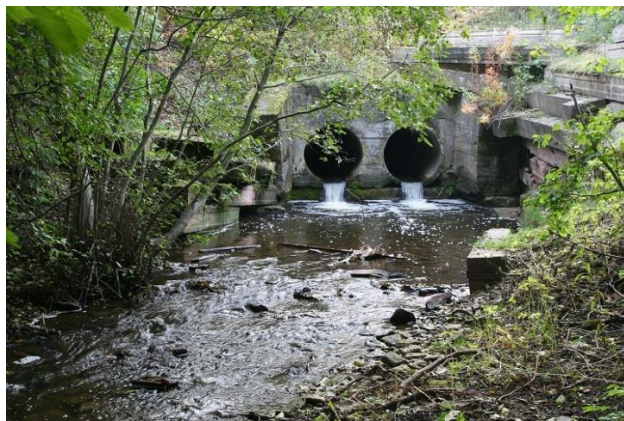
Joonis 11. Veeastmega teetruup Meriküla oja alamjooksul (R. Järvekül).
