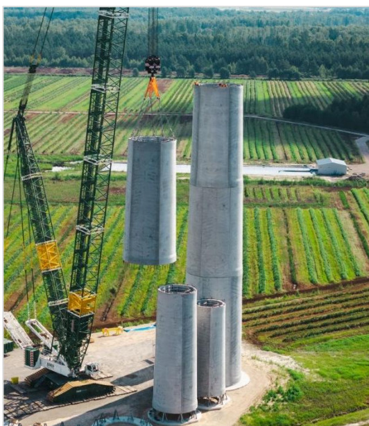
Joonised 14 ja 15. Monteeritavad betoontornid „Laflora“ tuulepargis (allikas: Consolis Latvija SIA)
